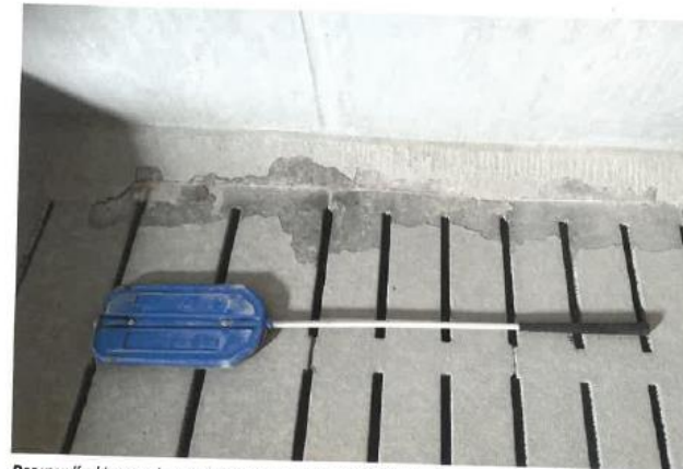
Der var udfordringer med epoxyens holdbarhed. Der blev løbende foretaget udbedringer af epoxyoverfladen mellem holdene.
